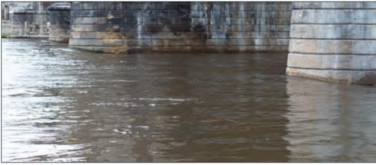
Abb. 2: Umströmung von Brückenpfeilern. Die von links kommende Strömung trifft auf die Pfeiler. Staut sich zunächst an und fließt dann beschleunigt herum, dabei fällt der Wasserspiegel ab. (Elbe in Dresden, Albertbrücke)
